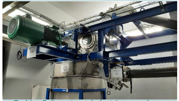
Turbine Pelton et sa génératrice asynchrone sur microgrid DC
